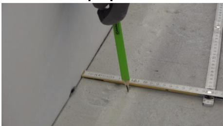
Профиль следует располагать по центру сечения бетонной плиты. Минимальное расстояние от профиля до края грани бетонной плиты должно составлять не менее 8 см. (для армированной плиты) и не менее 15 см. (для неармированной плиты)
