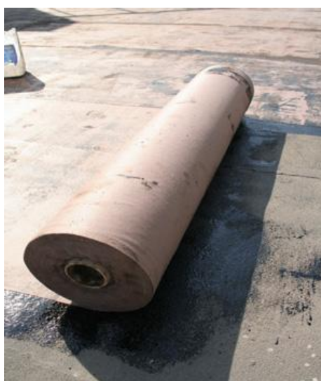
Рис. 13. Второе и последующие полотна армирующего материала укладываются по той же технологии с нахлестом 5-10 см или встык.
