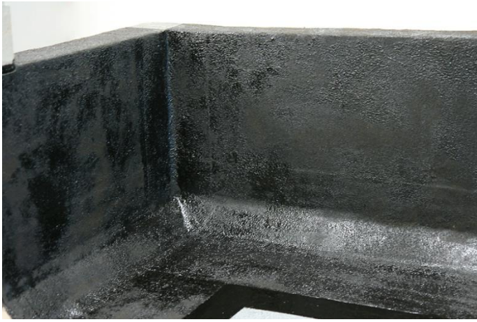
Рис. 19. Вид внутреннего угла примыкания после нанесения покрытия.
