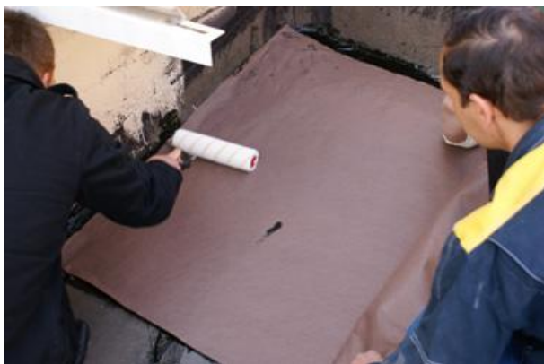
Рис. 10. Фиксация края полотна армирующего материала. После выравнивания полотно прикатывается велюровым валиком.
