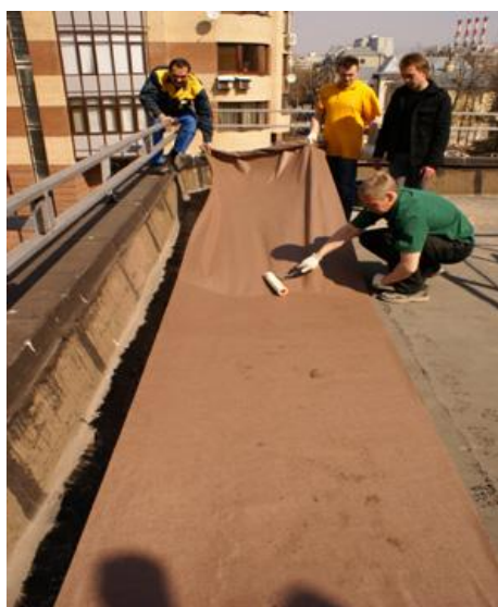
Рис. 12. Укладка полотна армирующего материала с прикатыванием его к поверхности с помощью велюрового валика.
