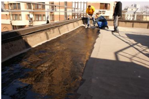
Рис. 11. После фиксации края полотна мастика наносится на всю длину укладки армирующего материала.
