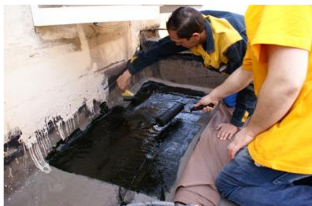
Рис. 9. Нанесение 1-го слоя мастики у края примыкания для последующей фиксации начала армирующего материала.
