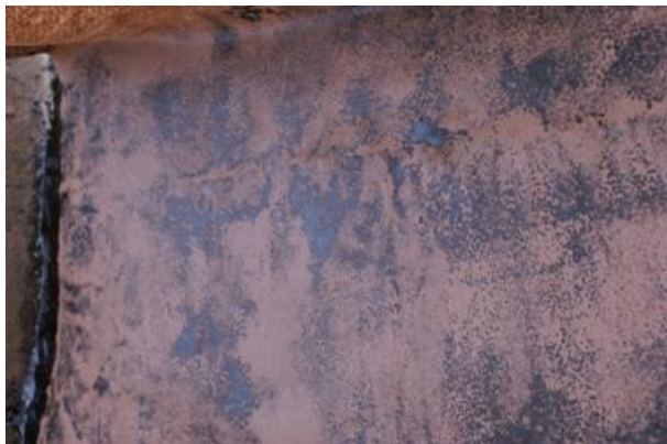
Рис. 14. Вид поверхности армирующего материала после укладки. Неокрашенные участки (в местах неровностей или дефектов поверхности основания) оставляются без пропитки и окрашиваются при нанесении 2-го слоя мастики.
