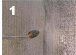
По всей длине трещин, швов, стыков, сопряжений, примыканий и вокруг ввода коммуникаций выполнить штрабы П-образной конфигурации сечением не менее 25x25 мм. Штрабы очистить щеткой с металлическим ворсом. Удалить рыхлый слой бетона (при наличии такового). Полости напорных течей разделать с помощью отбойного молотка на ширину не менее 25 мм и глубину не менее 50 мм с расширением внутрь (по возможности в форме «ласточкиного хвоста»). Очистить внутреннюю полость течи от рыхлого, отслоившегося бетона.
