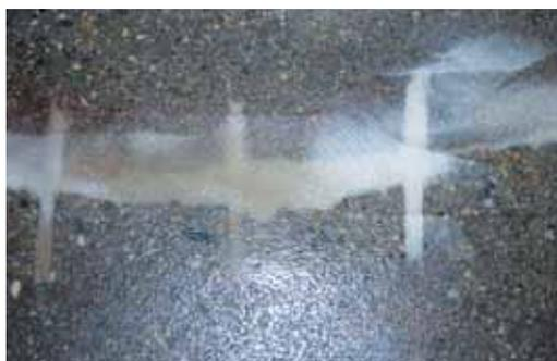
Появление трещин - неизбежное явление в бетонных работах. Мы можем говорить о двух причинах появления трещин в бетоне или стяжке. Первая причина связана с пластической усадкой и процессом бетонирования поверхности на стадии устройства бетона; другая - по причине усадки, перепадов температуры, внешними воздействиями, не профессиональным монтажом, перегрузкой поверхности и т.д.
